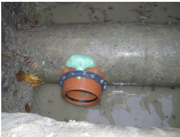
Stutzen mit Versiegelung der angebohrten Bewehrung
