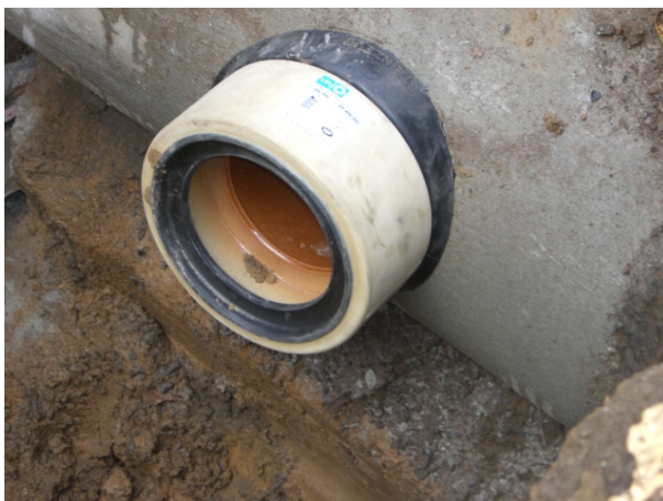
Anschlussstutzen der Firma Steinzeug
