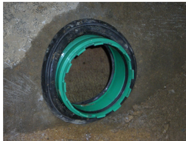
Anschlussstutzen der Firma REHAU
