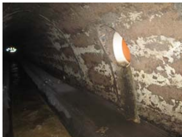
falsche Einbindehöhe
