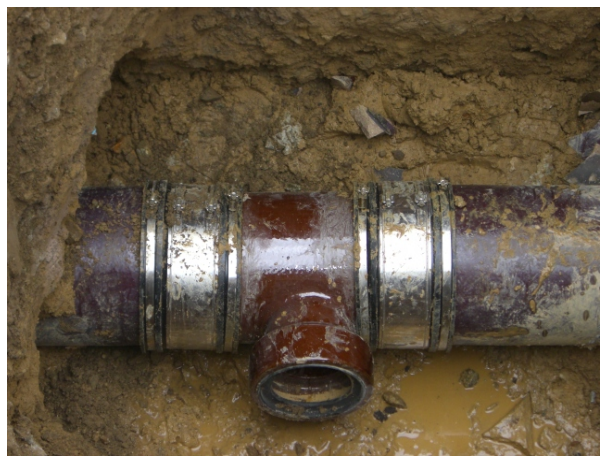
Formstück aus Stz incl. Canada-Manschetten
