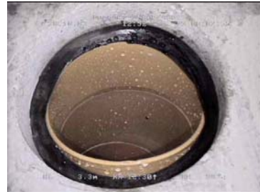
Dichtungsgummi gequetscht
