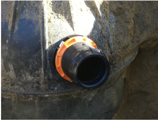
Anbindung an Kunststoffschacht
