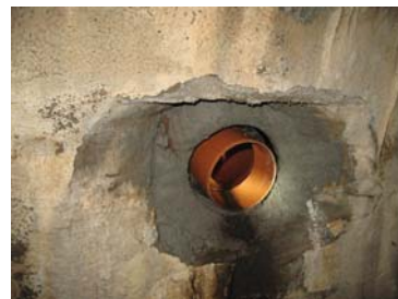
Einbindung mit Zerstörung des HK
