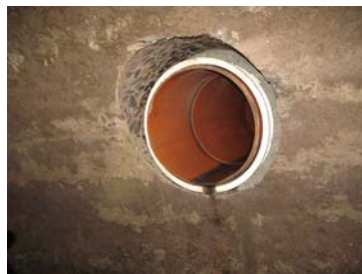
undichte Rohrführung
