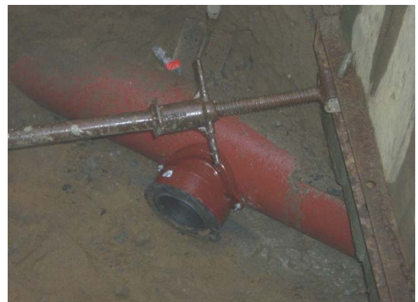
Sattelstück am Gussrohr (Saint Gobain)
