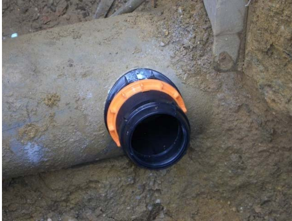
fachgerechte Anbindung mittels Stutzen
