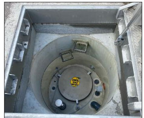
Blick in den Nutrioxschacht
