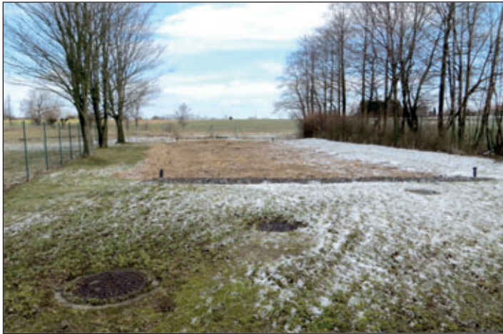
Die Schilfkläranlage Zur Ziegelei in Mohorn
