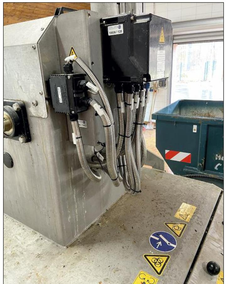
Zur Vermeidung von Rattenfraß in Metallschläuche gehüllte Kabel an der Rechenanlage
